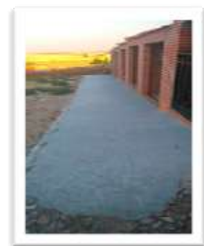
Adecuación de las calles
