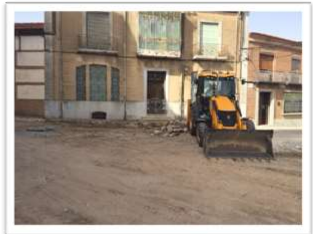
Primera fase de la obra (Entorno de San Nicolás)
