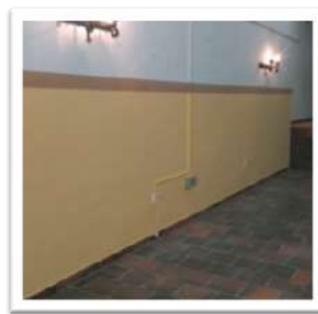
Tratamientos de estuco y antihumedad
