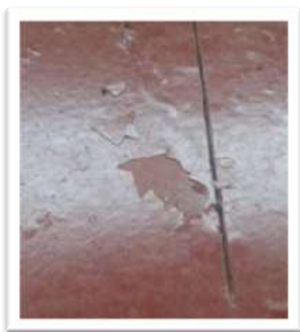
Importante deterioro de la pista de Fútbol Sala del Polideportivo Municipal
