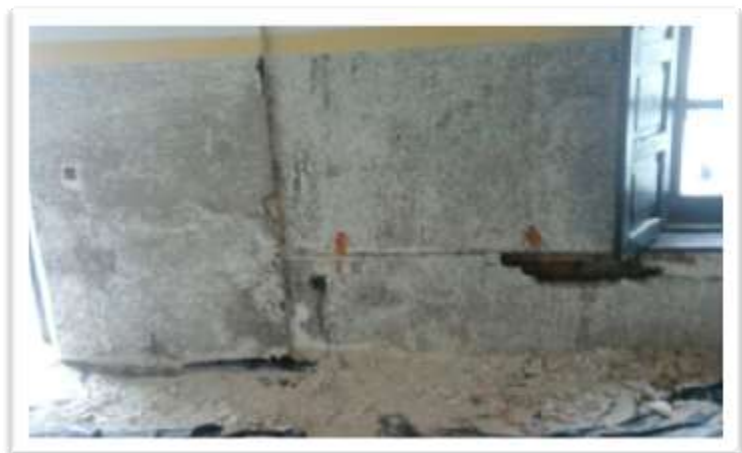
Picado del perímetro del ambigú
